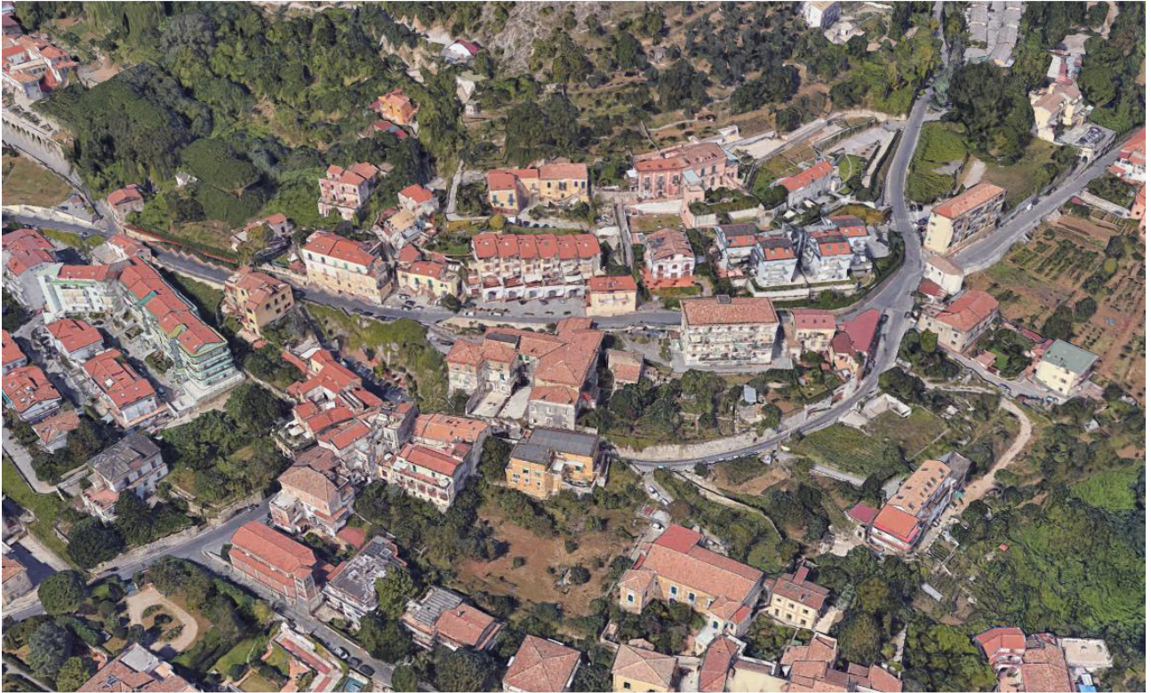
Vista Google Earth del borgo San Lorenzo prima degli interventi di demolizione
